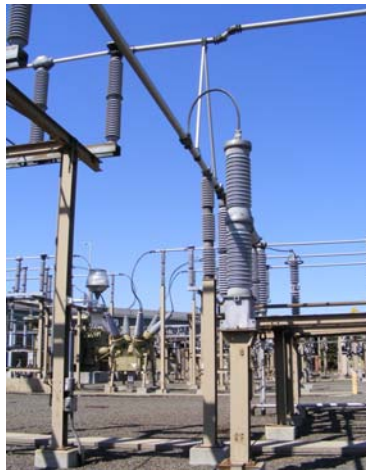
Fig. 20. 345 kV CCVT
